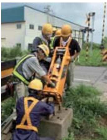
鉄道信号踏切設置工事
